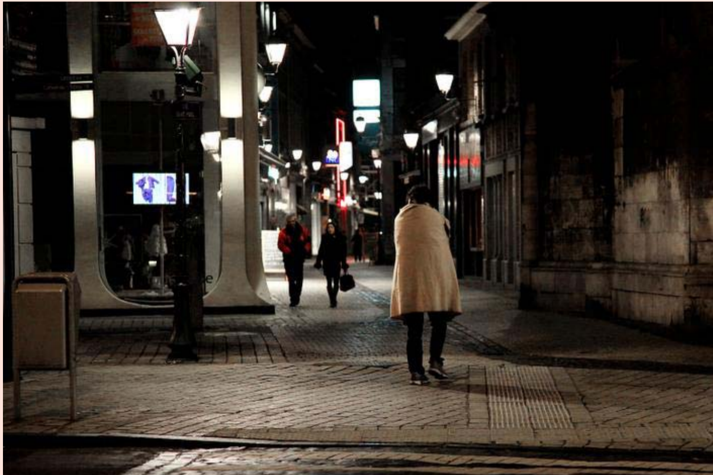
À Liège, 12 des luminaires installés ont une puissance d'au moins 250 W. En les remplaçant par du 140 W, dont la luminosité est équivalente grâce au progrès technologique, on divise la consommation (et la facture) par un facteur proche de deux. © MICHEL TONNEAU.
